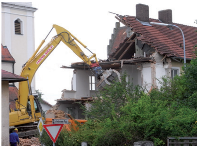
Im Mai 2014 verschwand mit dem Abbruch des Schulhauses ein Stück Ortsgeschichte
