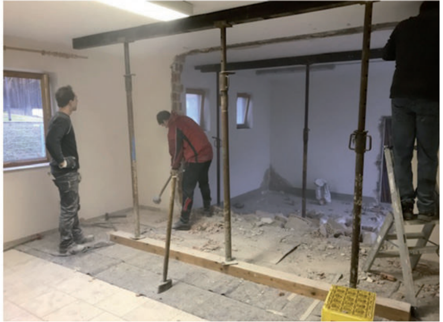
Durchbruch der Zwischenmauer
