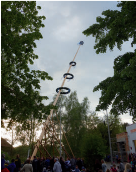
Meter für Meter ging es mit Muskelkraft und Holzstangen in die Senkrechte
