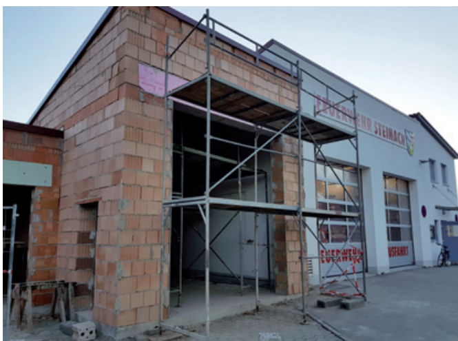
Der neue Anbau noch im Rohbau
